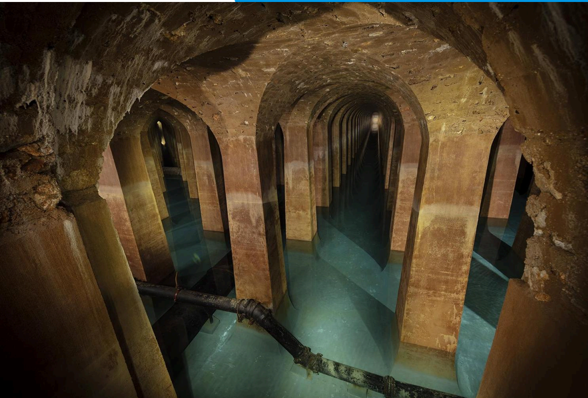
Le réservoir Montsouris permet de stocker les eaux acheminées vers Paris ©Stéphane Querbes
